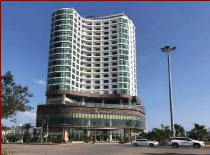
Dự án Alansea Đà Nẵng Alansea Da Nang Project
